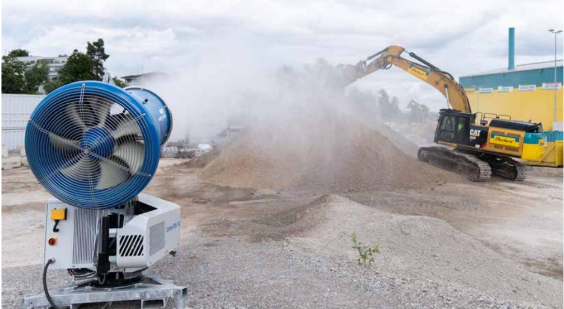
Рисунок 2.4 – Водяна гармата для пилопригнічення вентиляторного (турбінного) типу серії MobyDick Cannon
