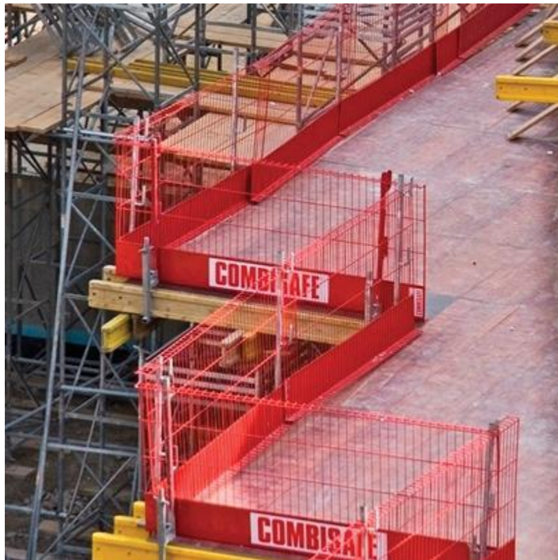
Рисунок 3.1 – Захисне огородження Combisafe
