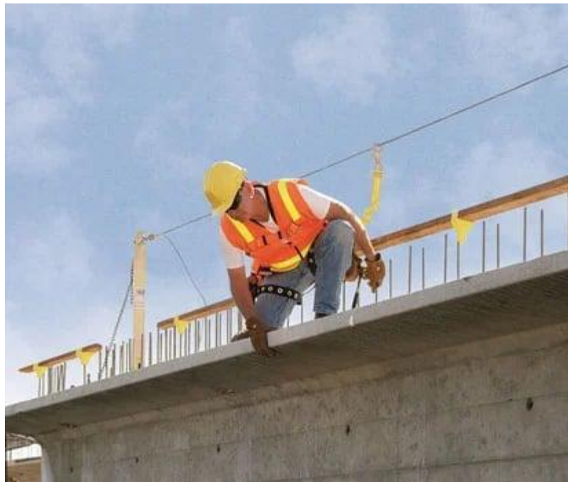
Рисунок 3.2 – Тимчасова горизонтальна анкерна лінія
