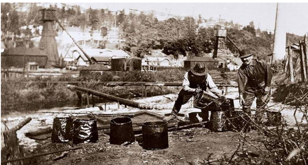
Рисунок 1.1 – Видобуток нафти з неглибоких ям вручну
