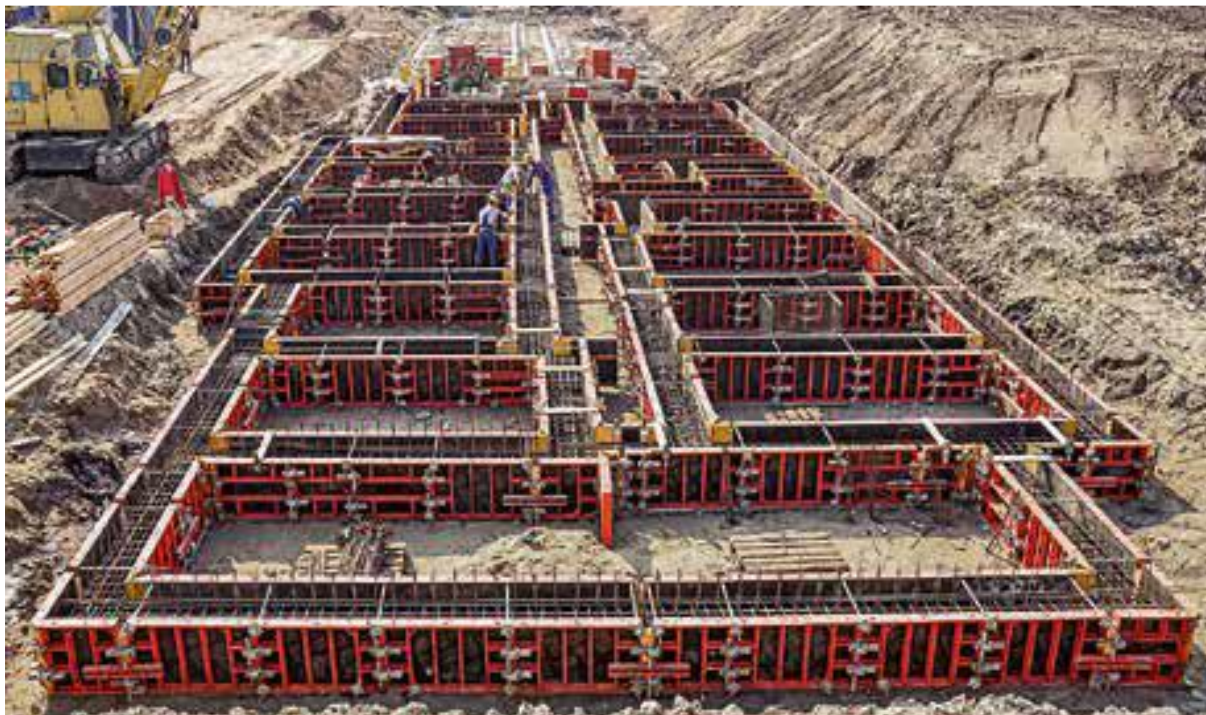
Рисунок 2.2 – Розкладка щитів опалубки PERI DOMINO
