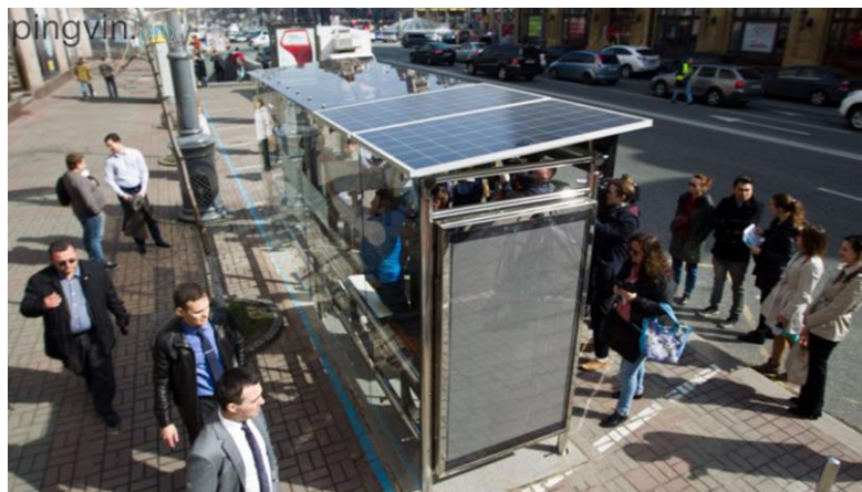
Рисунок 1.6 — Приклад зарядної станції з сонячними панелями на кінцевій зупинці електробуса
