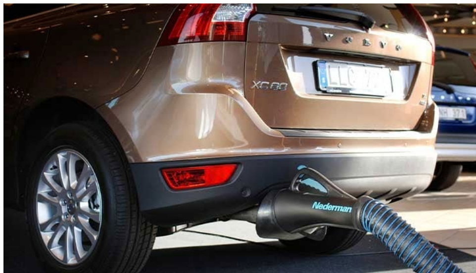
Рисунок 2.1 – Приклад використання місцевої системи видалення вихлопних газів типу Nederman Hose Reel
