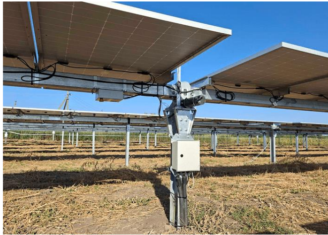
Рисунок 3.2 – Приклад використання трекеру для сонячної панелі [32]
