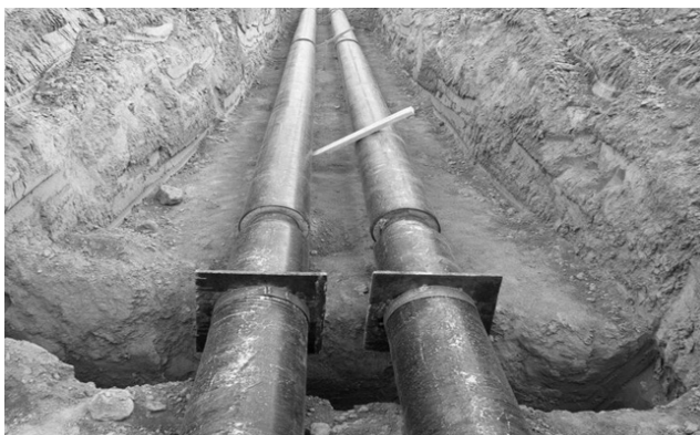
Рисунок 7.14 – Попередньо ізольовані нерухомі опори для підземної прокладки
