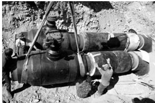
Рисунок 7.39 – Фрагмент монтажу арматури при підземній безканалній прокладці
