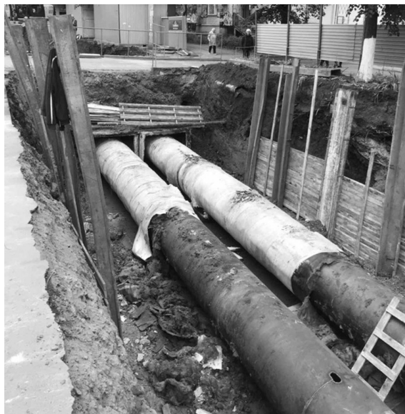
Рисунок 7.1 – Існуюча магістральна тепла мережа діаметром 820 мм перед заміною її на нову попередньо ізольовану
