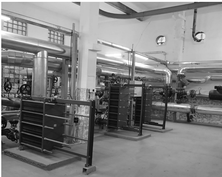
Рисунок 8.14 – Пластинчасті теплообмінники системи гарячого водопостачання. Двоступенева схема
