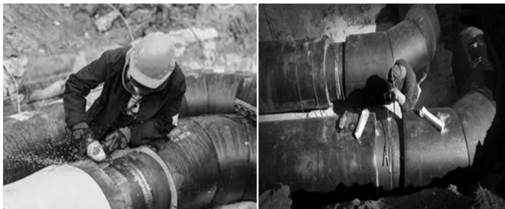
Рисунок 7.15 – Зварювання з'єднань трубопроводів теплотраси
