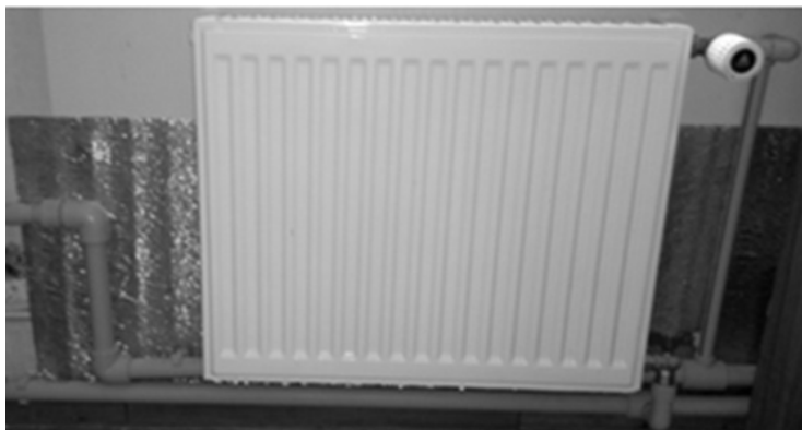
Рисунок 5.8 – Фрагмент нового обігрівача та регулятора температури «Danfoss»
