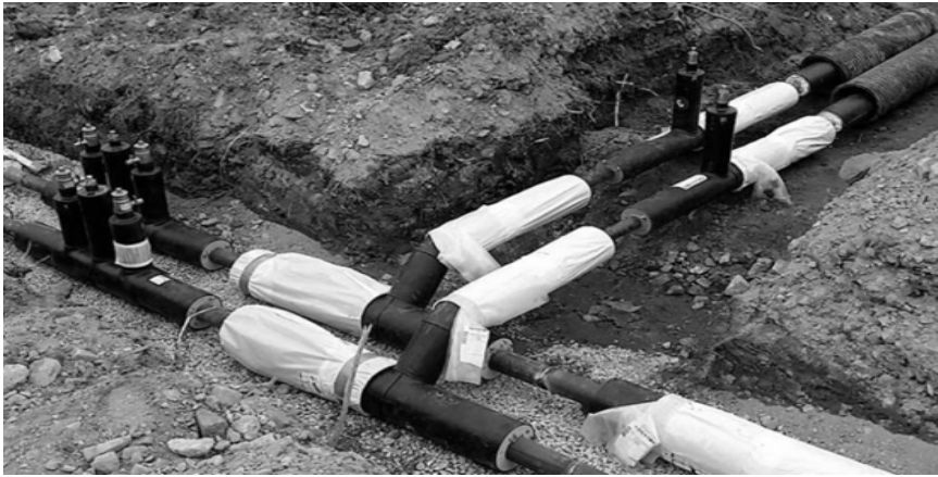
Рисунок 7.38 – Фрагмент теплофікаційного вузла приєднання
