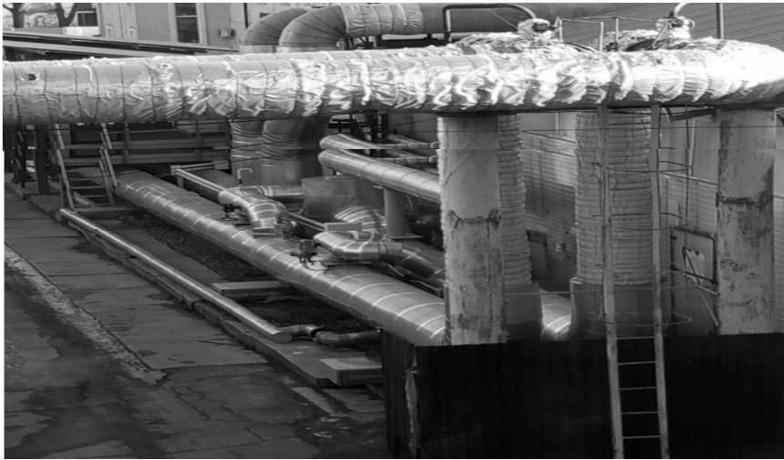
Рисунок 7.41 – Теплофікаційний вузол приєднання при надземній прокладці
