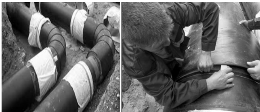
Рисунок 7.16 – Муфтування з'єднань трубопроводів теплотраси
