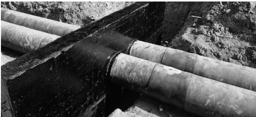
Рисунок 7.29 – Тримальні конструкції нерухомих розвантажених опор у ґрунті
