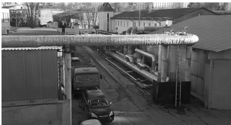
Рисунок 7.19 – Надземна прокладка теплотраси над проїздами в промзоні. Праворуч показаний вузол підключення абонента.
