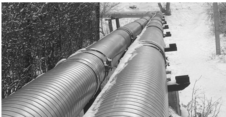
Рисунок 7.17 – Попередньо ізольовані труби
