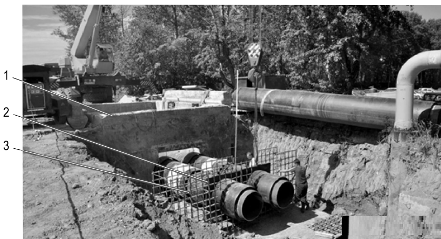
Рисунок 7.30 – Устрій навантаженої посиленої нерухокої опори на діаметрі 820 мм:
