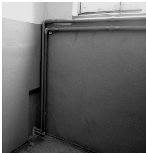
Рисунок 5.5 – Фрагмент прокладки горизонтальних трубопроводів системи опалення в сходових клітках
