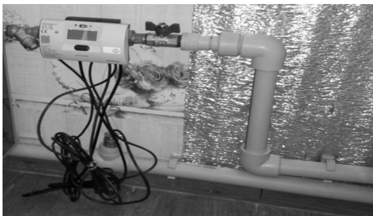
Рисунок 5.7 – Фрагмент установки квартирної лічильника тепла
