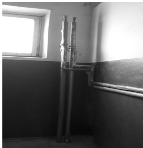
Рисунок 5.4 – Фрагмент прокладки трубопроводів системи опалення на сходових клітках
