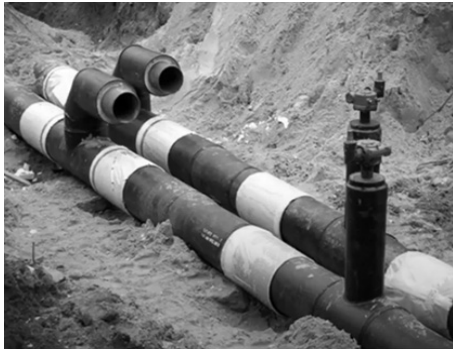
Рисунок 7.39 – Фрагмент монтажу арматури при підземній безканалній прокладці
