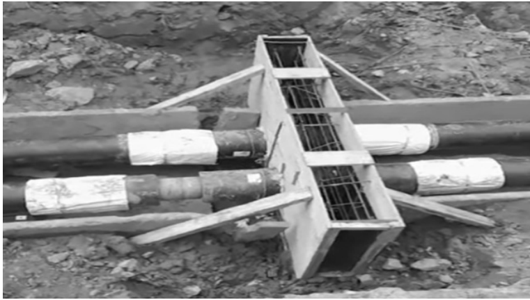
Рисунок 7.27 – Бетонування нерухомої опори
