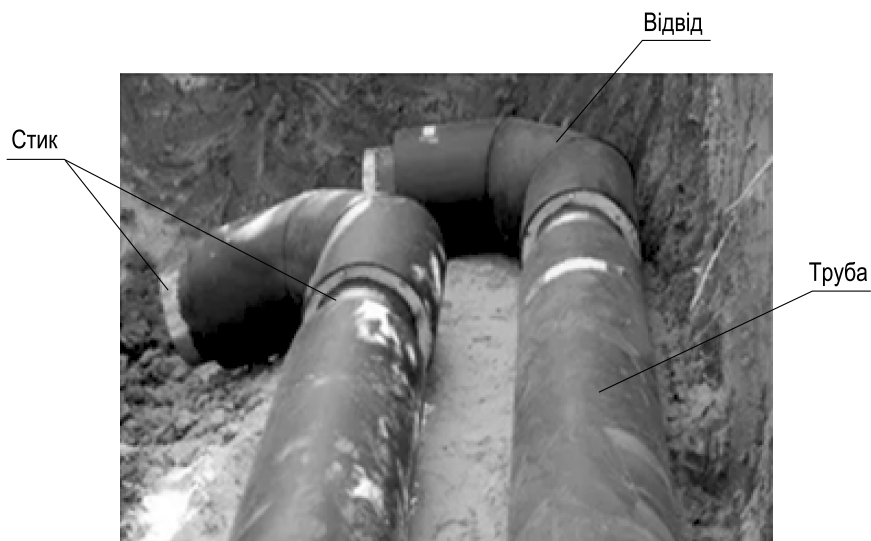
Рисунок 7.13 – Стикування відводу і прямого ділянки труби
