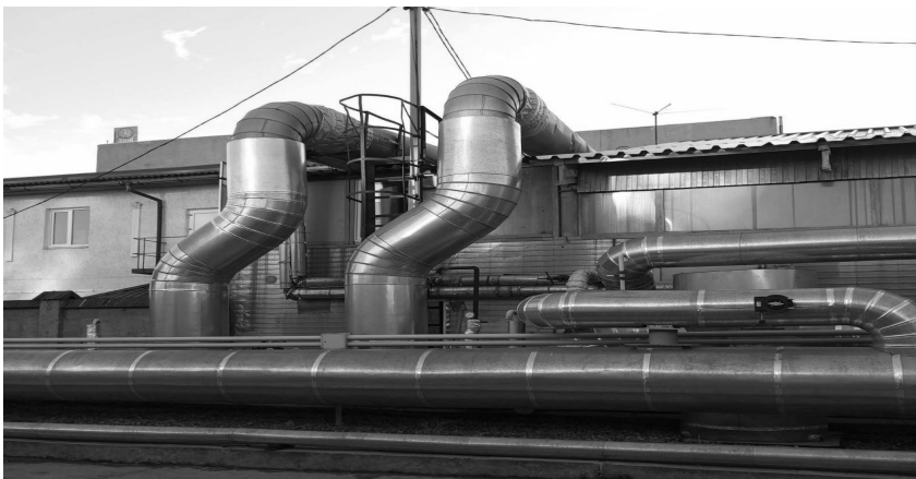
Рисунок 7.40 – Теплофікаційний вузол приєднання при надземній прокладці
