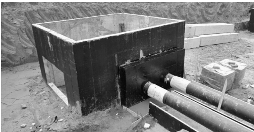
Рисунок 7.36 – Фрагмент залізобетонної теплової камери перед засипкою ґрунтом
