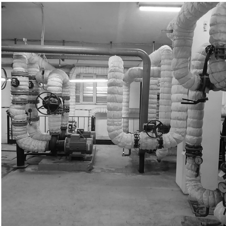
Рисунок 8.15 – Гарячоводні насоси на ТРС
